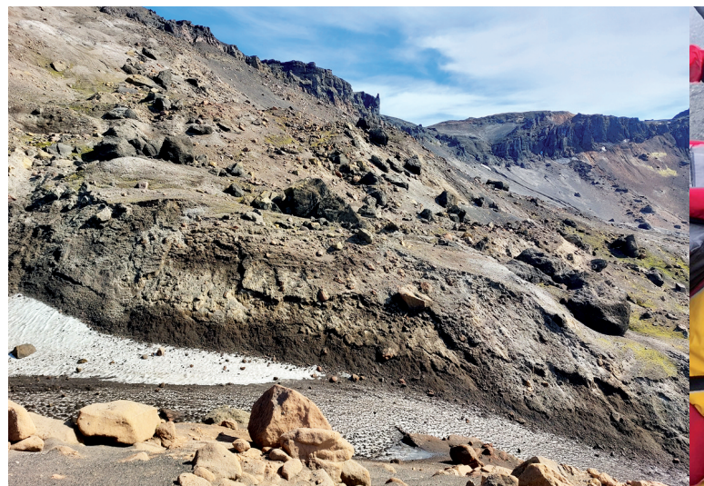
Figure 8. Dépôts d'un ancien glissement de terrain dans la zone centrale (~7 m d'épaisseur). Photo © Nicolás Serrano.
